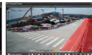
乌鲁木齐机场扩建工地
