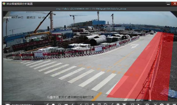
乌鲁木齐机场扩建工地
