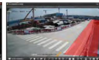
乌鲁木齐机场扩建工地
